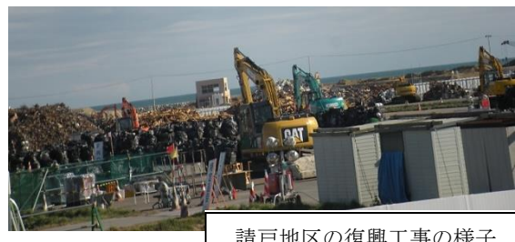
請戸地区の復興工事の様子
